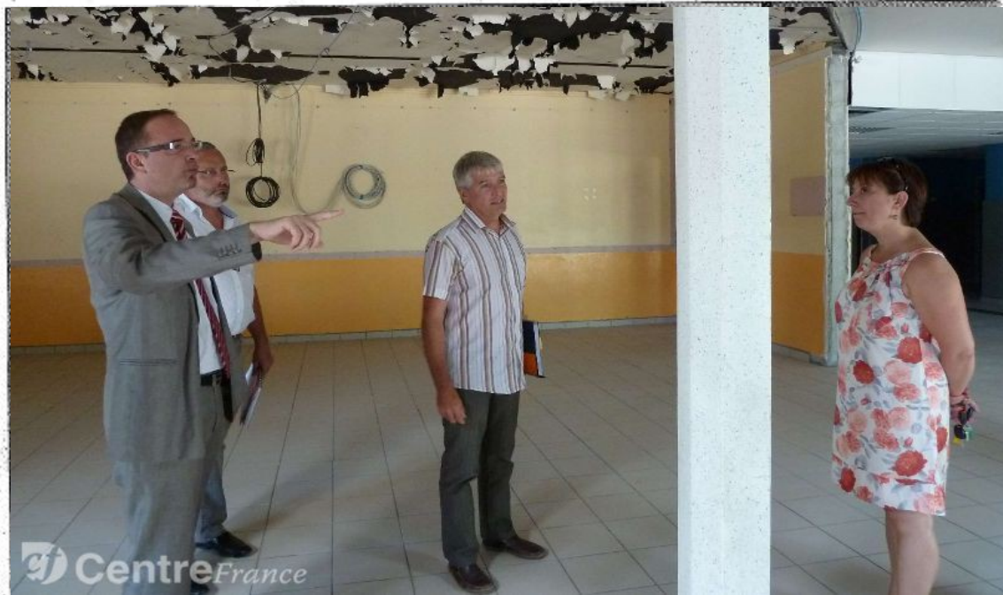
HALL D'ENTRÉE. Il sera agrandi de près de 90 mètres carrés grâce à la suppression de l'ancienne salle de permanence et repeint avec des couleurs claires. PHOTO DAVID ANGEVIN
